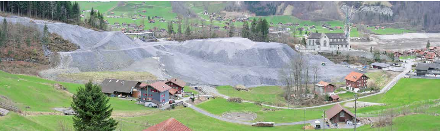
Deponie des Ausbruchmaterials aus dem A8-Umfahrungstunnel Lungern, März 2010. Bild: Archiv Pirmin Gasser
