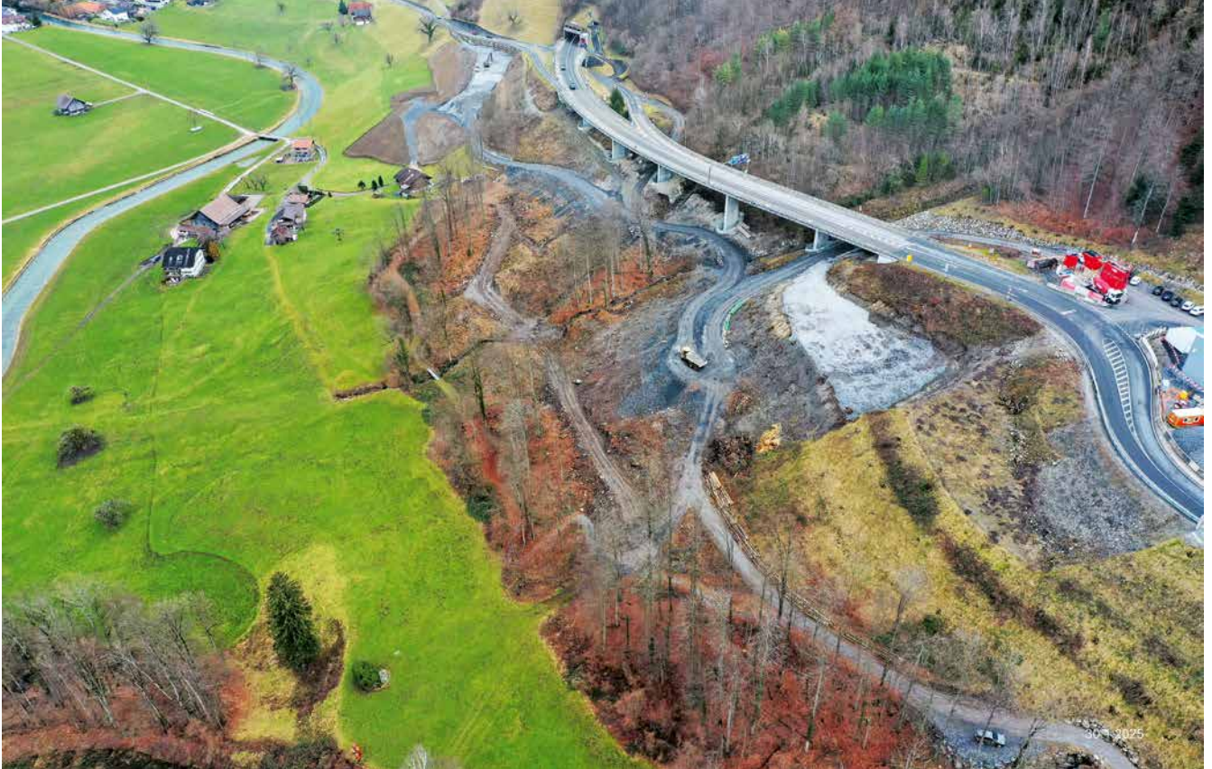
Schüttung von Tunnelausbruch für die beiden Widerlager der neuen Kantonsstrassenbrücke Buochholz [TERRAplan].
