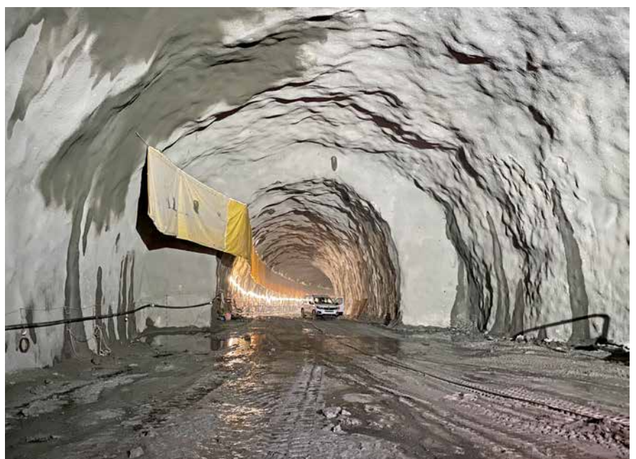
Ausbruch einer grossen Kaverne für eine Ausstellbucht im Tunnel Kaiserstuhl [Amberg Engineering AG].
