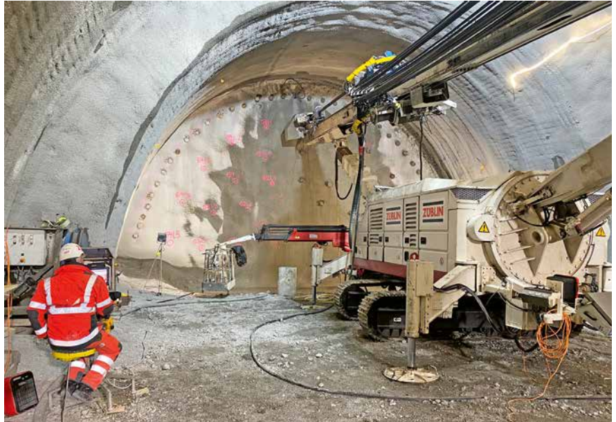
Erstellung Jettingsäulen zur Sicherung im Lockergestein [Amberg Engineering AG].
