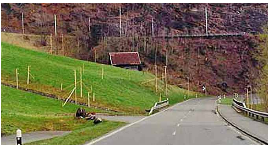
Situation der Brünigstrasse im Abschnitt nach der «Steilowwi» Richtung Lungern. Aufnahme Ende der 1990er-Jahre, vor Baubeginn des A8-Umfahrungstunnels Lungern. Hier befindet sich jetzt das Nordportal. Im oberen Bildbereich ist die Bahnlinie sichtbar. Links, ausserhalb des Bildes, wäre das Gebiet des Lawinenkegels auf Seite 17 unten zu sehen. Bild: Archiv Pirmin Gasser
