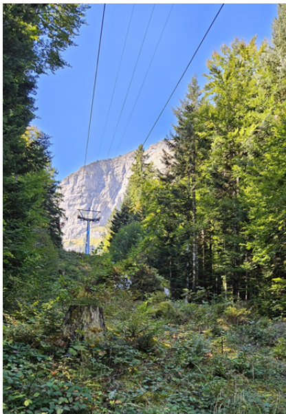
Abb. 16: Niederhalt unter Seilbahn
