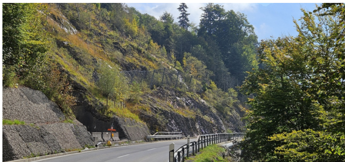
Abb. 6: Steinschlagschutznetz oberhalb Kantonsstrasse
