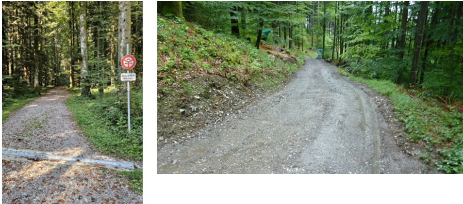
Abb. 4 und 5: Waldstrasse und forstlicher Maschinenweg
