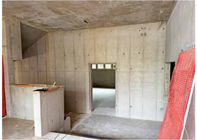
Die Baustelle am 9. Juni 2026.
