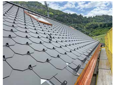
Die Baustelle am 15. Juni 2026.
