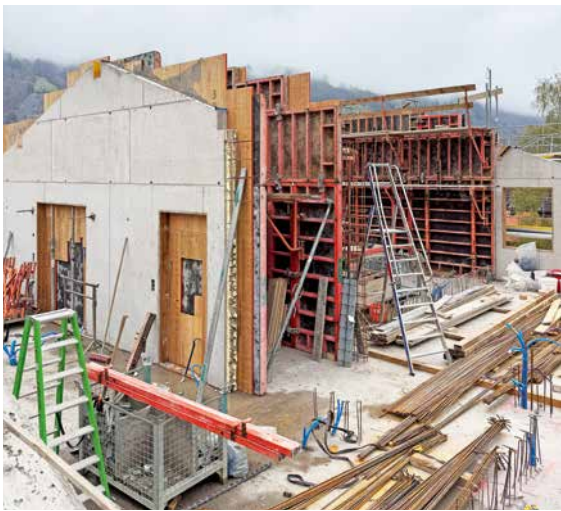
Die Baustelle am 13. April 2026.
