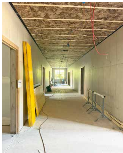
Die Baustelle am 2. Juli 2026.
