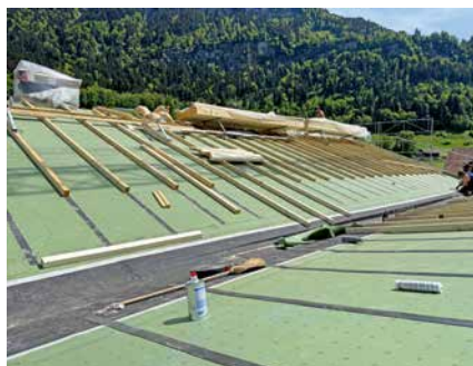
Die Baustelle am 21. Mai 2026.
