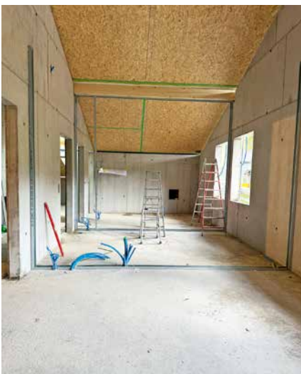
Die Baustelle am 11. Mai 2026.
