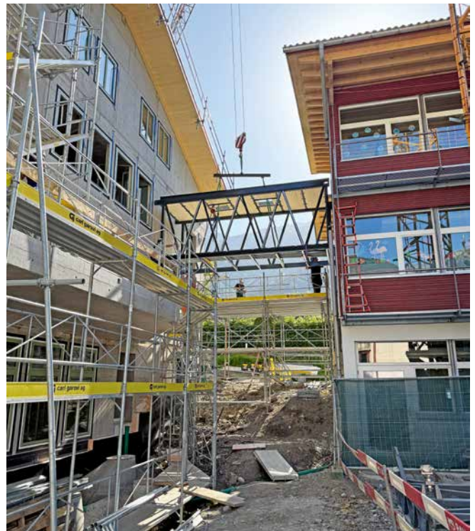
Die Baustelle am 26. Mai 2026.
