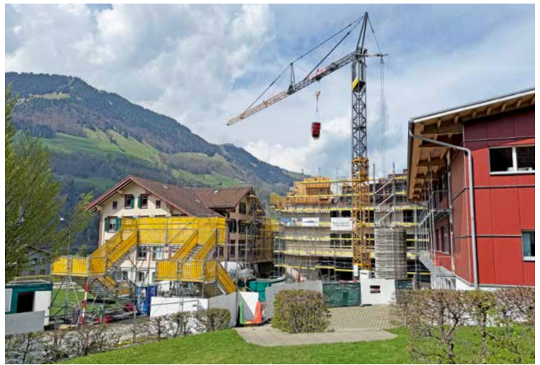
Die Baustelle am 20. April 2026.
