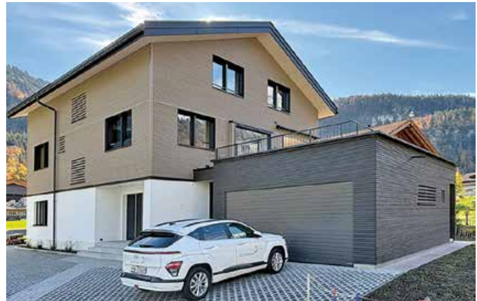
Zimmerei: Einfamilienhaus Della Torre, Bürgi.
