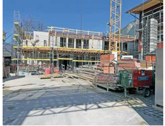
Die Baustelle am 20. März 2026.
