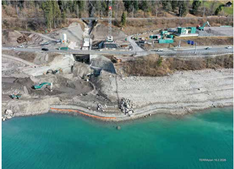
Abbildung 2: Der Fokus im Winter 25/26 lag auf dem Bereich Steinlauri. Das Gerinne wurde vergrössert, im Lungnersee ein Auffangraum für Naturereignisse ausgehoben und die Widerlager für die neue Brücke der N8 oberhalb der Brünigstrasse vorbereitet (TERRAplan, Februar 2026)
