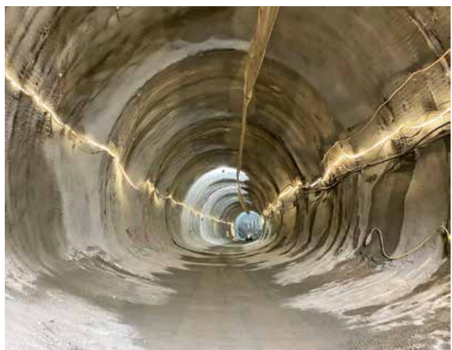
Abbildung 4: Abgeschlossener Südvortrieb in der Lockergesteinsstrecke (Amberg Engineering AG, Februar 2026)
