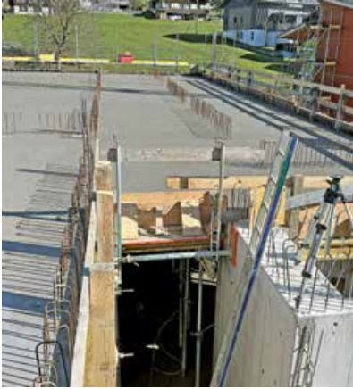
Die Baustelle am 20. März 2026.
