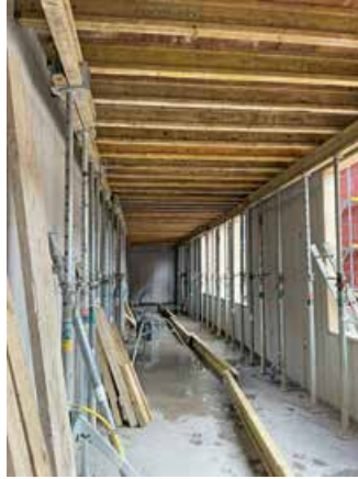
Die Baustelle am 20. März 2026.
