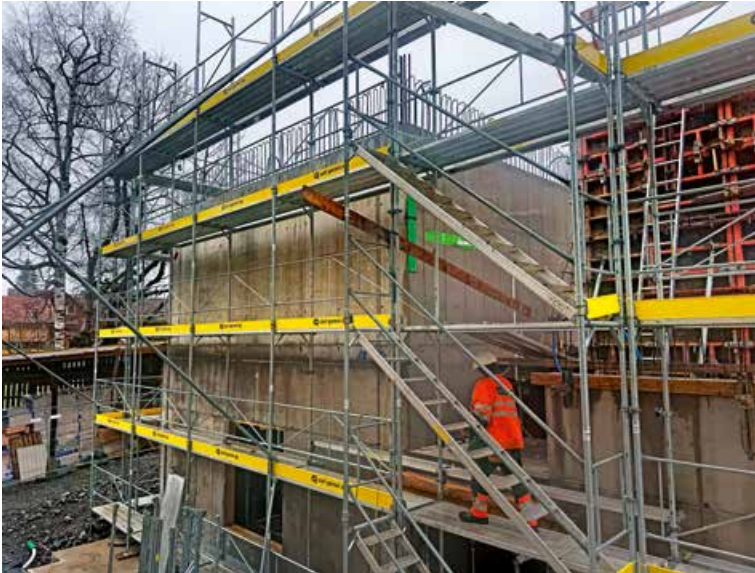
Die Baustelle am 16. Februar 2026.
