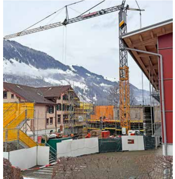
Die Baustelle am 19. Februar 2026.
