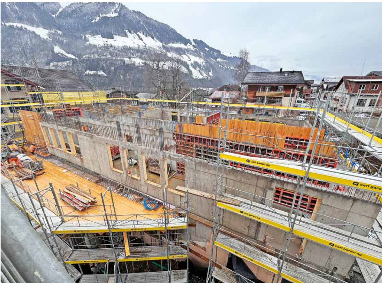
Die Baustelle am 19. Februar 2026.
