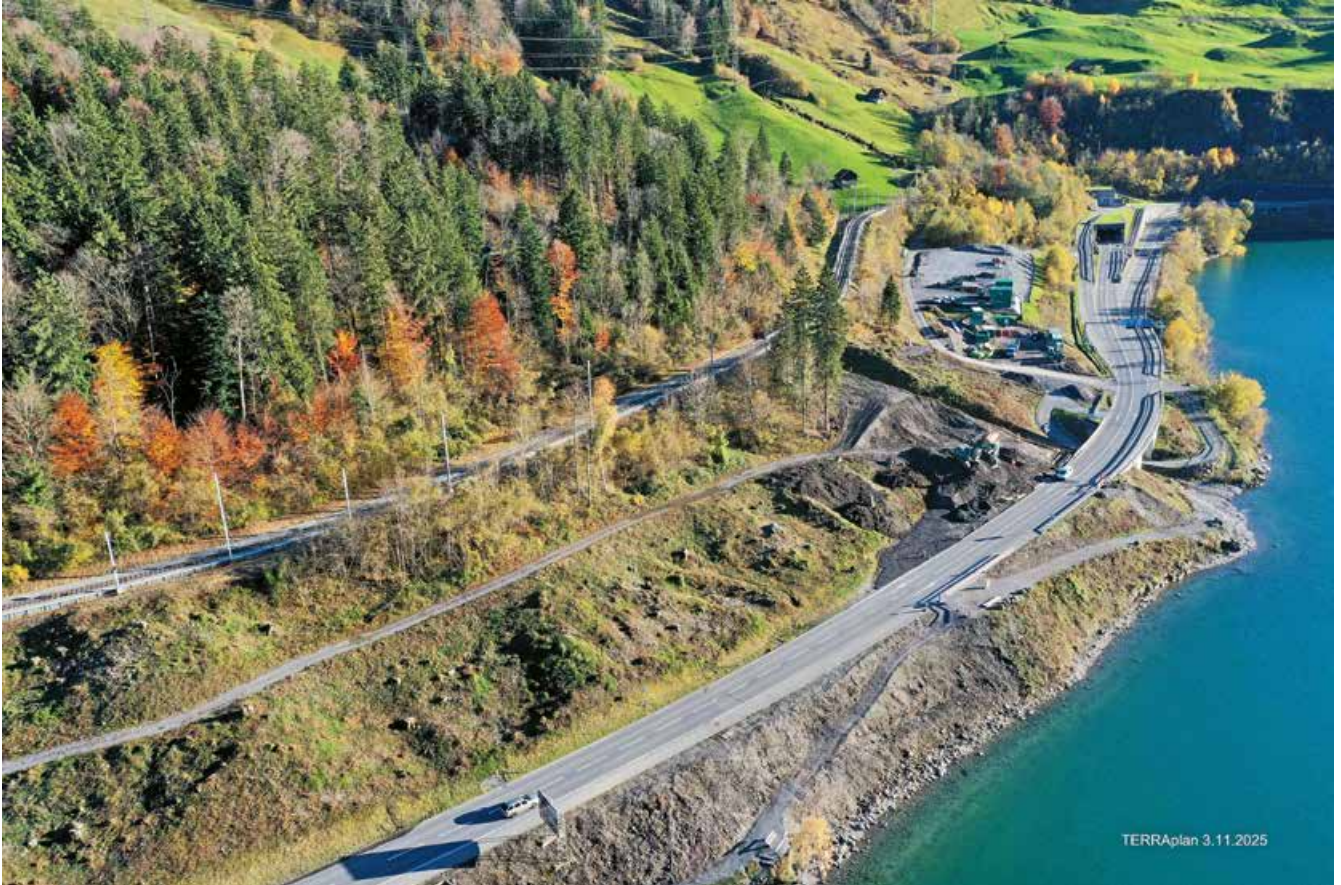
Abbildung 1: In anspruchsvoller Topographie, zwischen der Brünigstrasse und dem Trassee der Zentralbahn entsteht der neue Nationalstrassenabschnitt der N8 (TERRAplan, November 2025)
