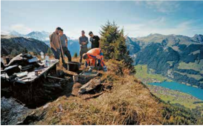
Arbeiten am Fundament.
