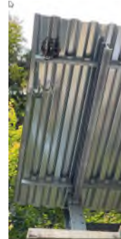
Steinschlag, Steinsplitter schwache Intensität
