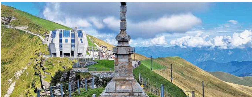
Das Gipfelgebäude «Fiori di pietra» vom Tessiner Architekten Mario Botta auf dem Monte Generoso.
