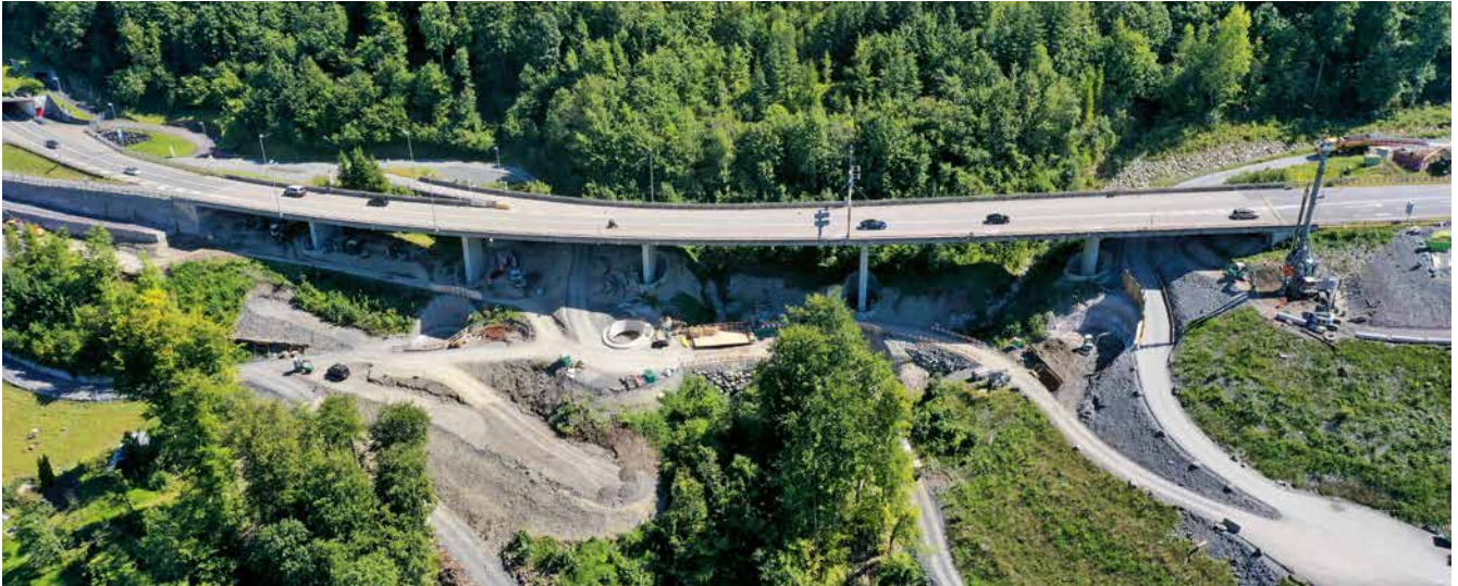
Abbildung 3: Bestehende Buochholzbrücke. Vorbereitung der fünf neuen Schachtfundationen für die zweite Buochholzbrücke (TERRAplan).
