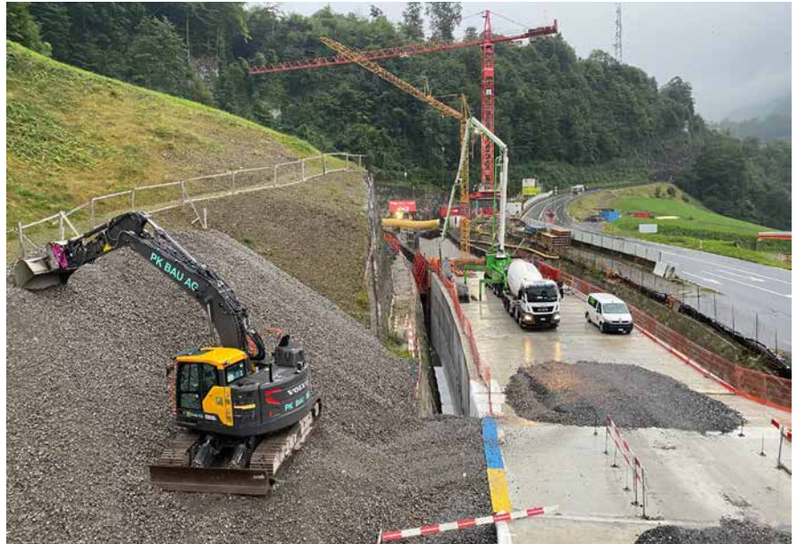
Abbildung 1: Hinterfüllung des Tagbautunnels mit Ausbruchmaterial im Norden (Amberg Engineering AG).
