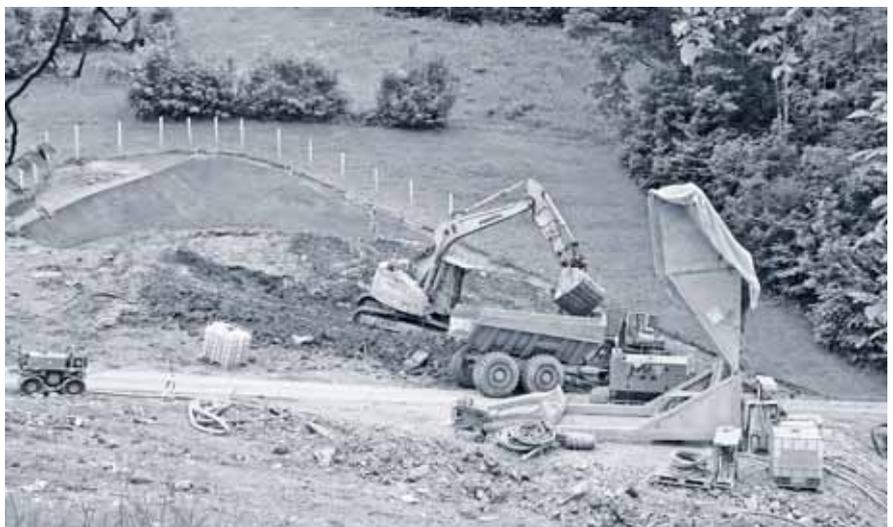
Vorbereitungsarbeiten für den Installationsplatz (oben) und Voreinschnitt Druckschacht.
