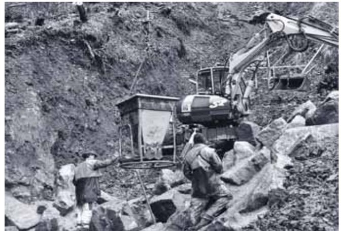
Bilder zum Schwandgraben. Links: Anrissicherung mit Holzkasten und Hangrost. Rechts: Einbau der Raubetrinne.
