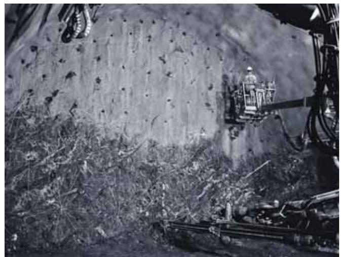
Bild links: Südportal. Rechts: Tunnelbrüst im Haupttunnel, Zündverbindungen kurz vor dem Sprengen.
