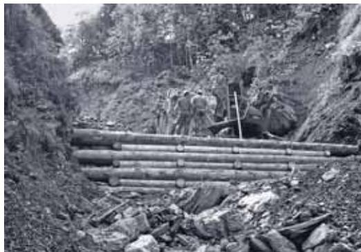
Bilder zum Schynberggraben. Oben: Seitenleitwerk aus Fichte und Douglasie. Mitte: Holzkasten mit Seitenleitwerken. Unten: Unterste Sperre auf Fels.
