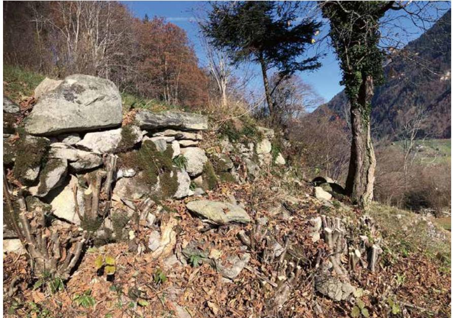
Aus der alten Trockensteinmauer im Geissweg drohten sich Steine zu lösen und sie stellte dadurch ein Sicherheitsrisiko dar.
