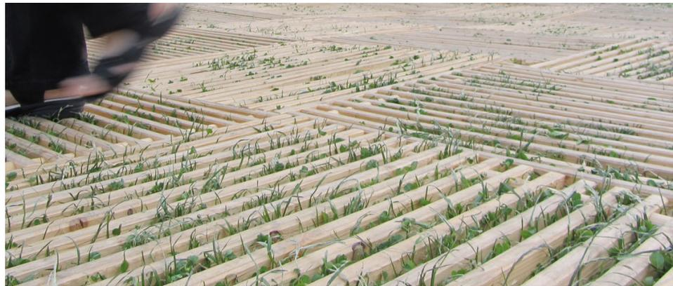
Abb. 6: Beispiel eines Holzrostes für Parkierungsflächen (Passareco, 2020)
