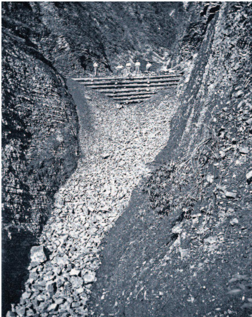
Bei einem schweren Unwetter am 21. Juli 1955 wurde die Strasse im Wendbachgraben in die Melchaa hinunter gerissen. Nach der provisorischen Wiederherstellung am 3. August 1955 musste der Strassenkörper rechts in den Fels gesprengt werden.
