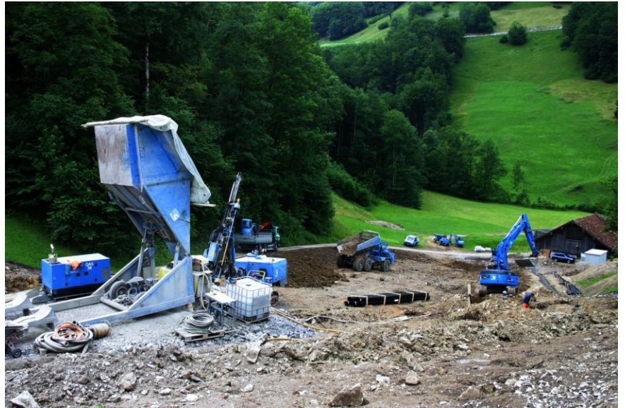
Vorbereitungsarbeiten für den Installationsplatz
