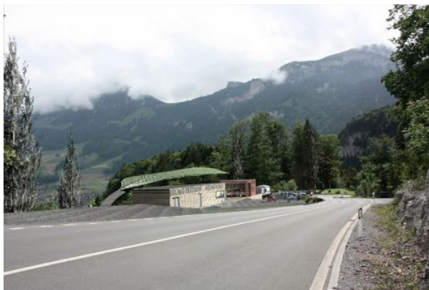
Zufahrt Bergseitig vom Brünig
